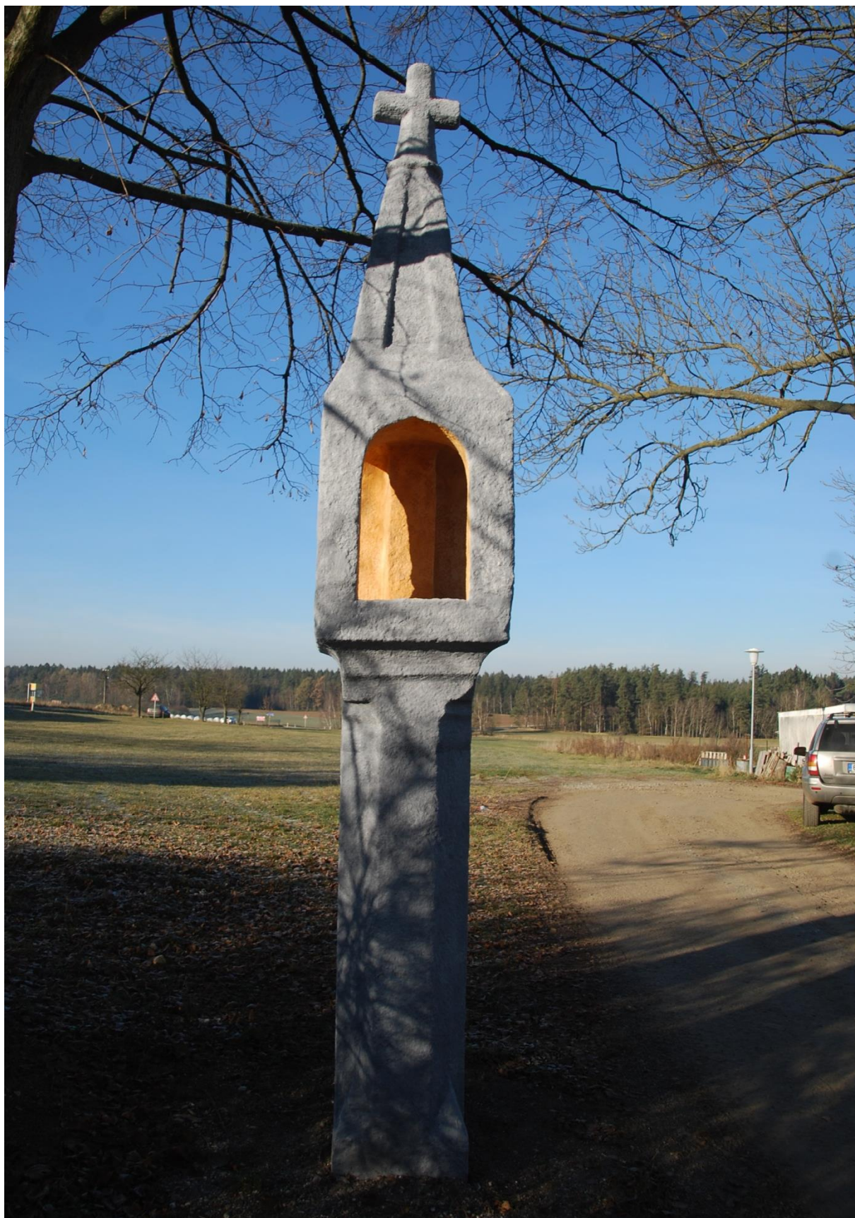
Stav po restaurování, bílý podkladový vápenný nátěr a na něm barevná vrstva. Celkový pohled.
