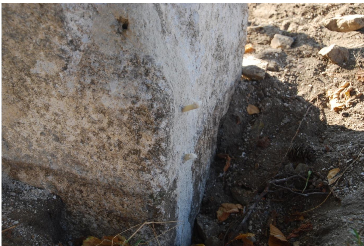
Průběh restaurování. Injektáž prasklin epoxidovou pryskyřicí přes trubičky a zajišťující tmely. Detailní pohled na patku díku.
