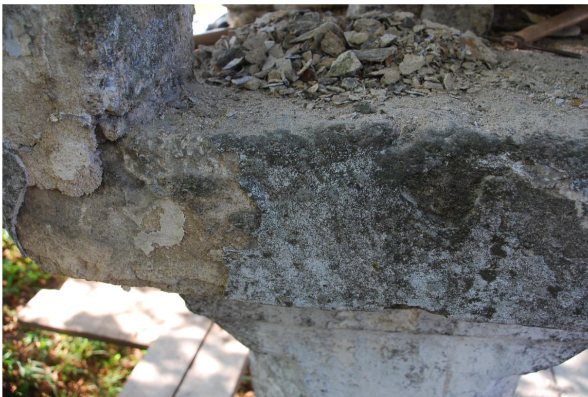
Průběh restaurování. Snímání nevhodných cementových malt a pletiva. Detailní pohled na pilířky a výklenek.
