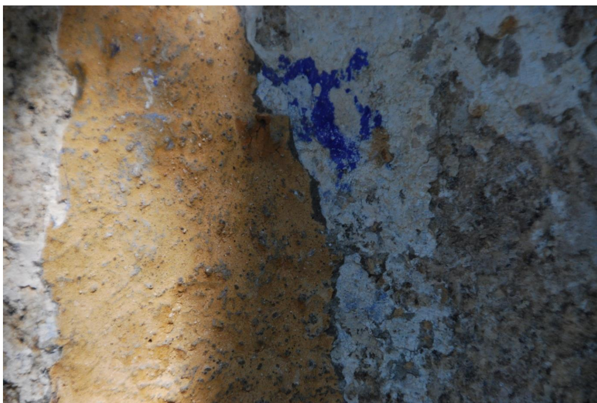
Průběh restaurování. Snímání nevhodných cementových malt a pigmentů. Detailní pohled na výklenek.
