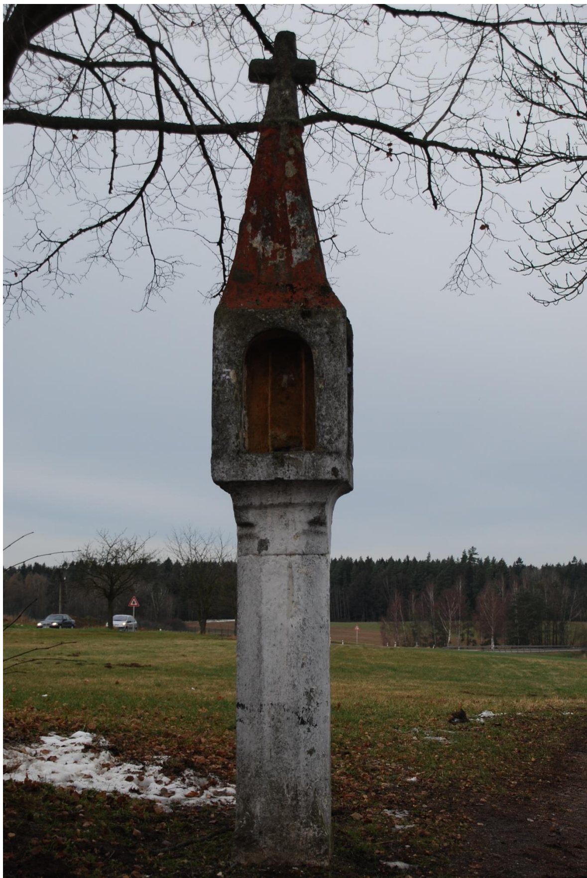
Celkový pohled na boflí muka, patrné vyhnutí stíky. Stav památky před restaurováním.
