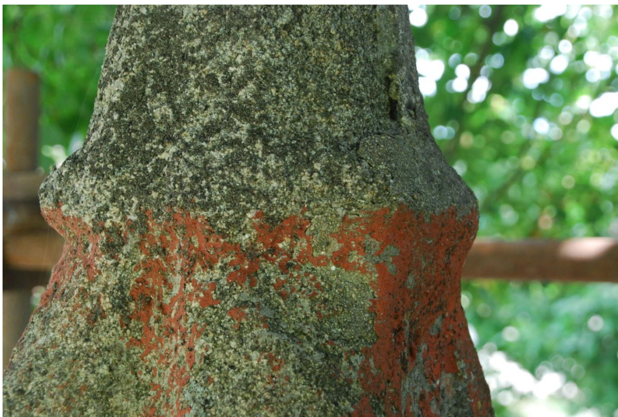
Detailní pohled na bofíík muka. Pohled na vrcholový kříž, který je uzavřený pod silnou cementovou vrstvou. Patrná i ztráta povodních tvarů. Stav památky před restaurováním.
