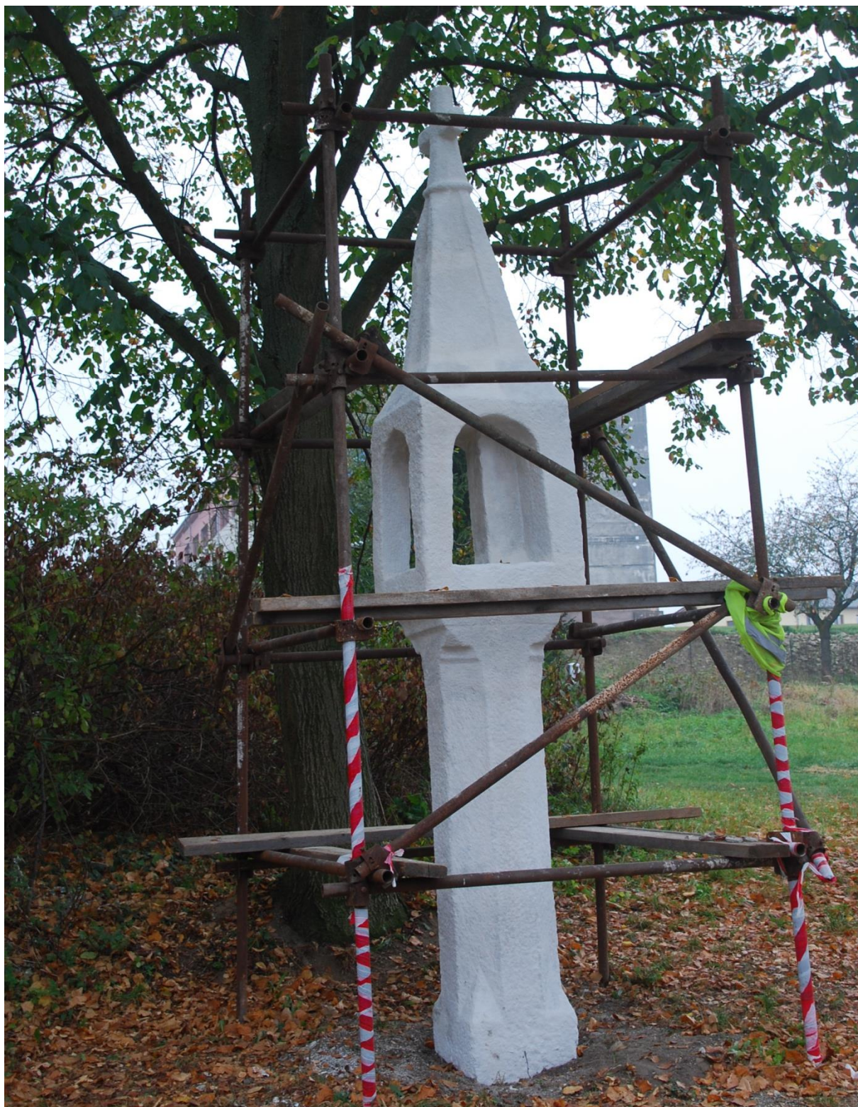
Průběh restaurování, bílý podkladový vápenný nátěr. Celkový pohled.
