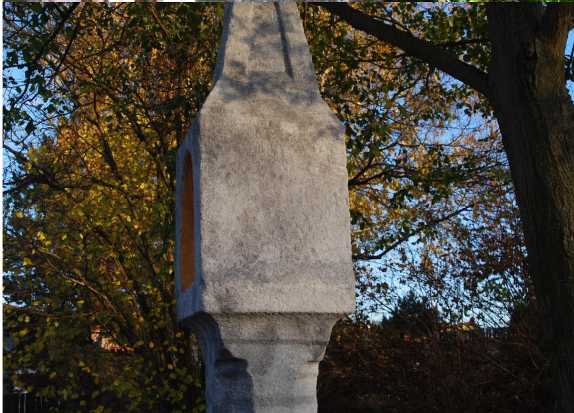
Stav před a po restaurování. Důležitý pohled.
