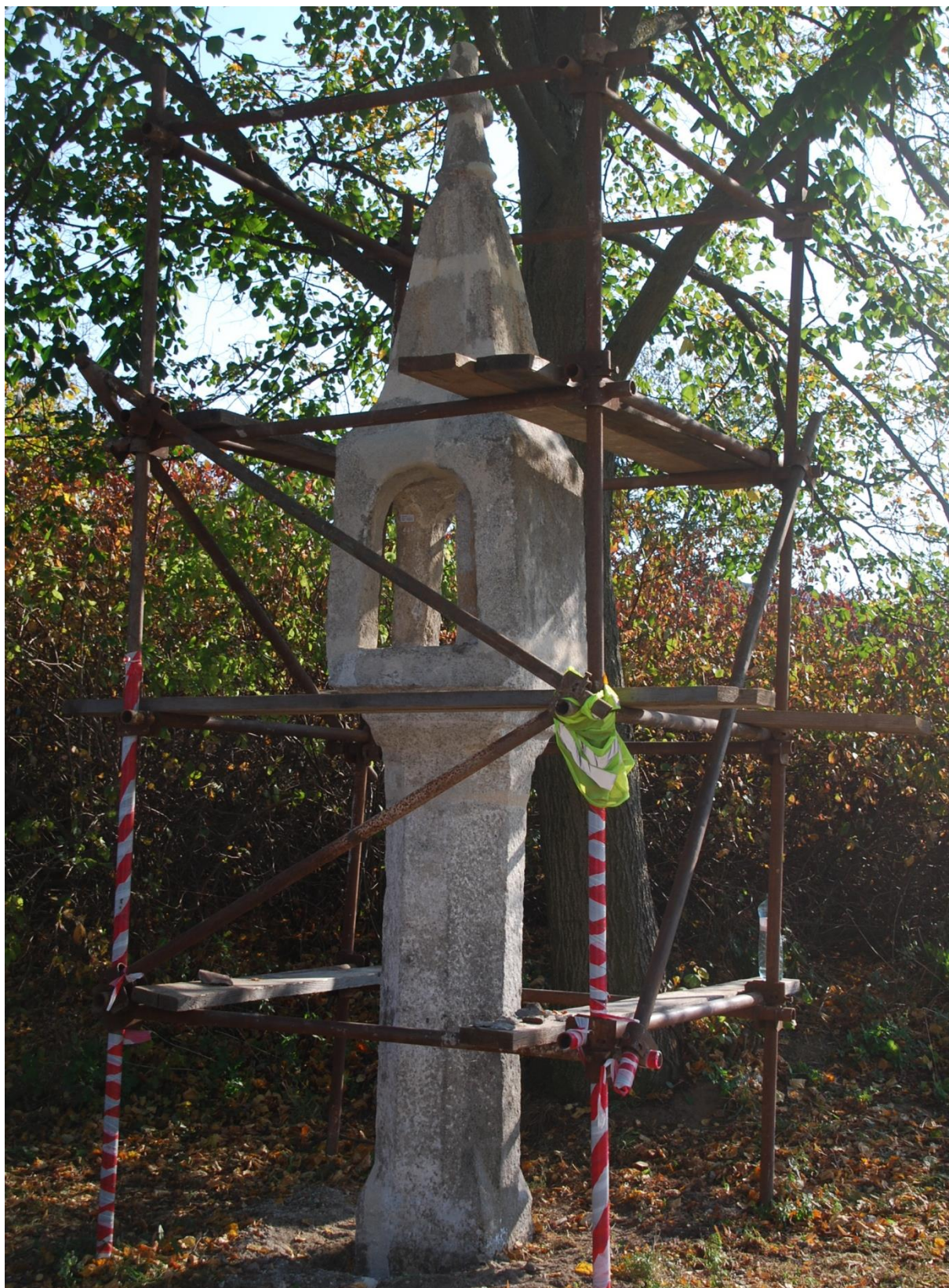
Průběh restaurování, stav po tmelení, před barevným nátěrem. Celkový pohled.
