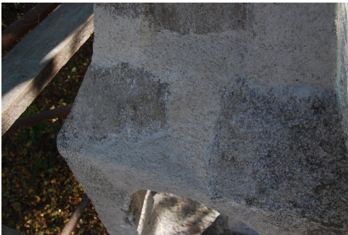
Průběh restaurování, stav po tmelení, před barevným nátěrem. Detailní pohled.
