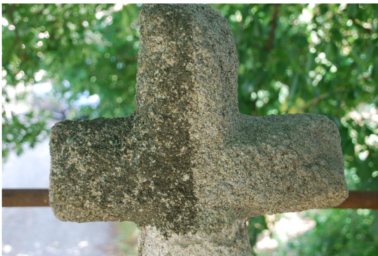
Průběh restaurování. Detailní pohled na dílo ukazuje škodu způsobenou biologickým napadením.
