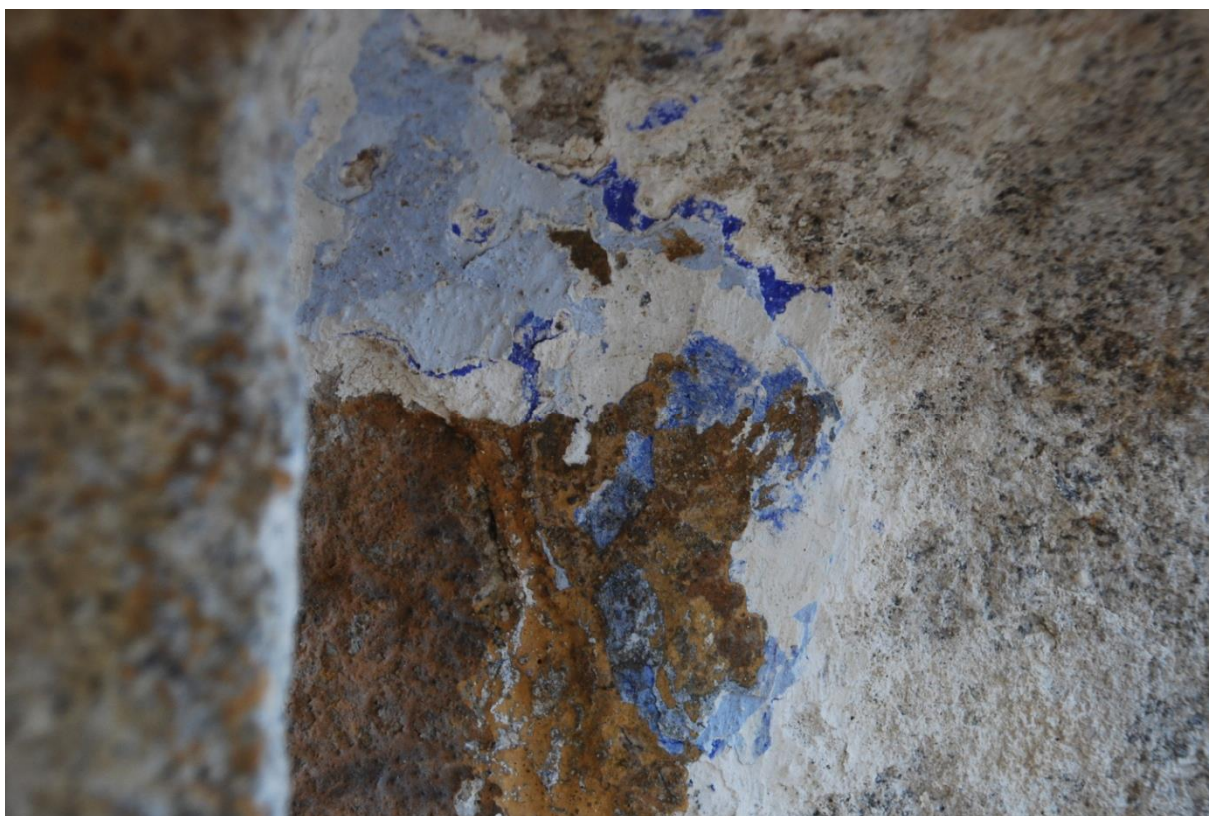
Průběh restaurování, stav po snímání, zachovaná barevná souvrství.
