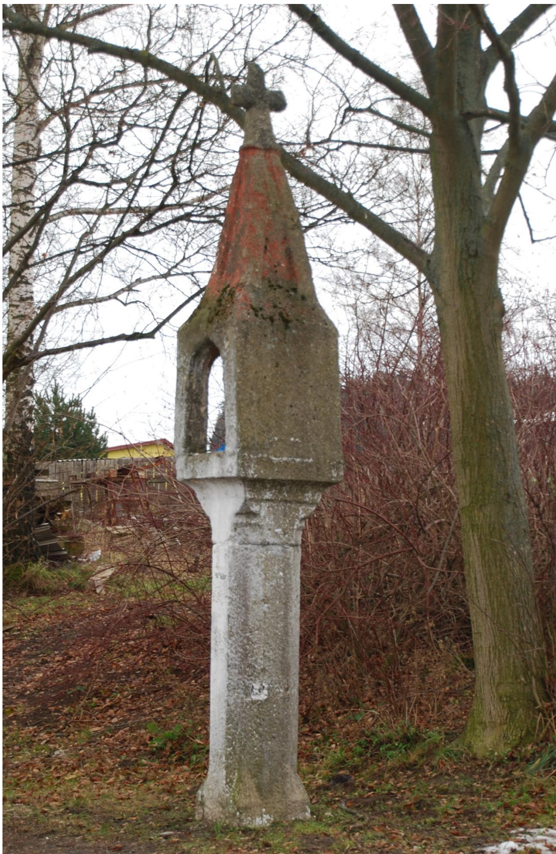
Celkový pohled na bofíí muku, patrné vyhnutí stíky. Stav památky před restaurováním.
