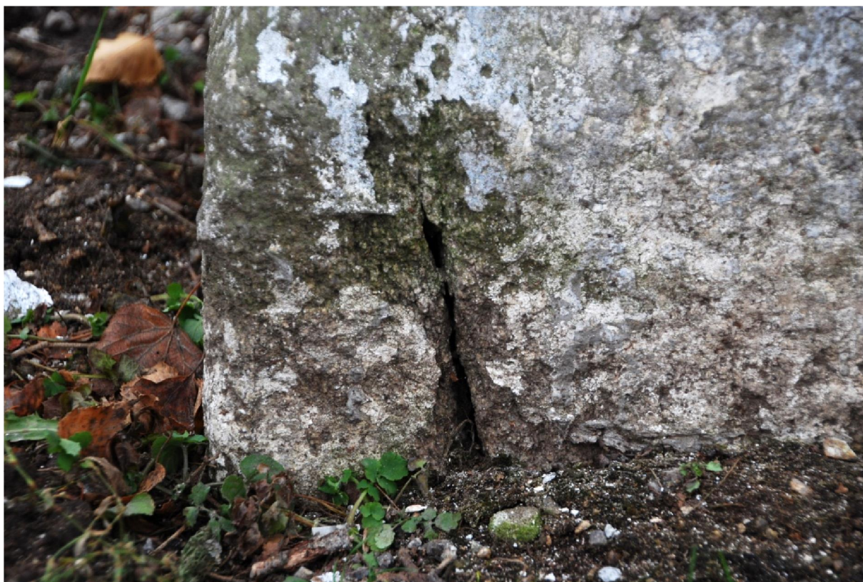
Detailní pohled na bofí muka. Pohled na plochu výklenku, s odli-ným barevným rozhráním (pravd podobn o-et eno fermeffí) a dále praskliny v patce d íku. Stav památky p ed restaurováním.
