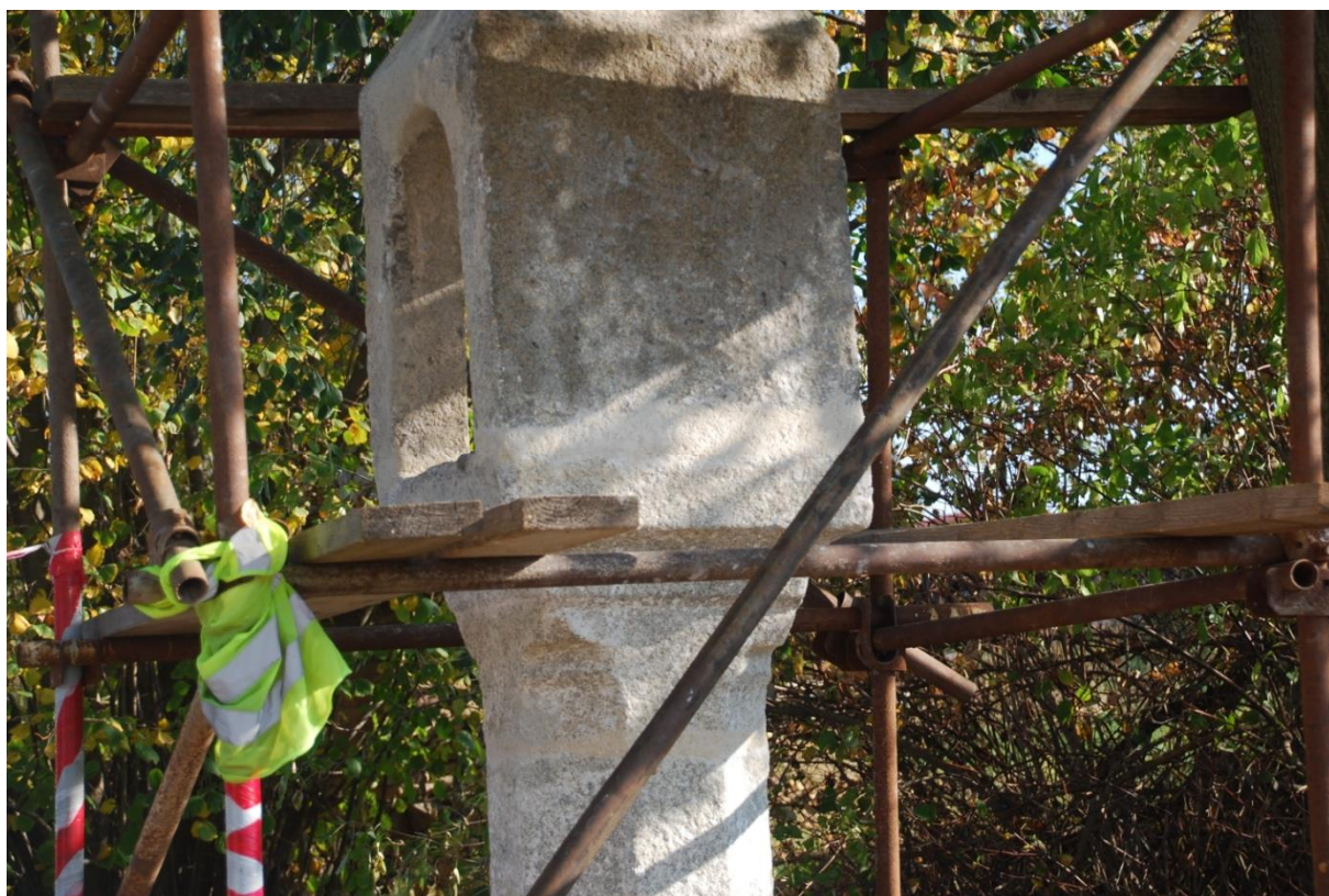
Průběh restaurování, stav po tmelení, před barevným nátěrem. Dílčí pohled.
