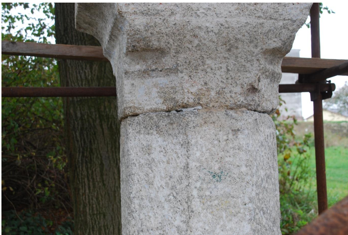
Průběh restaurování, stav po snímání, před tmelením.
