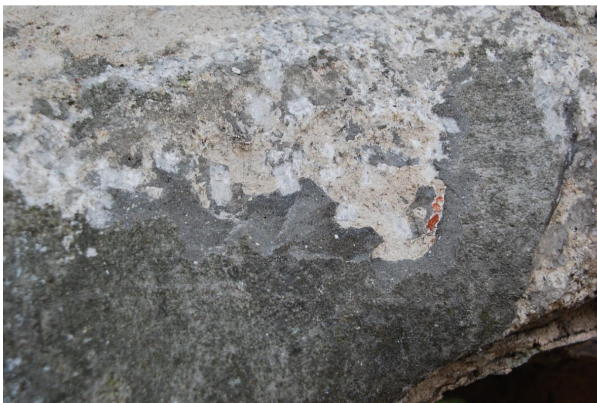
Průběh restaurování. Snímání nevhodných cementových malt a pletiva. Detailní pohled na křížovou částí.
