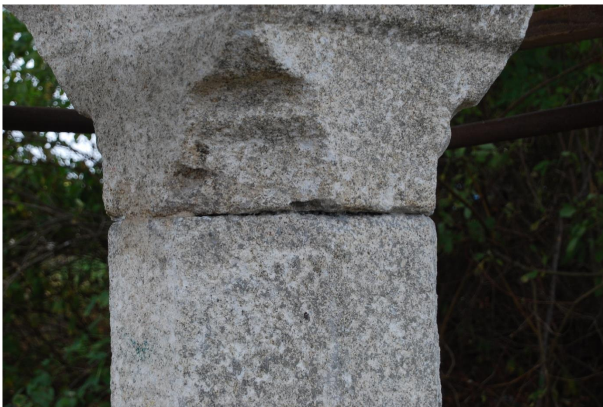
Průběh restaurování, stav po snímání, před tmelením.
