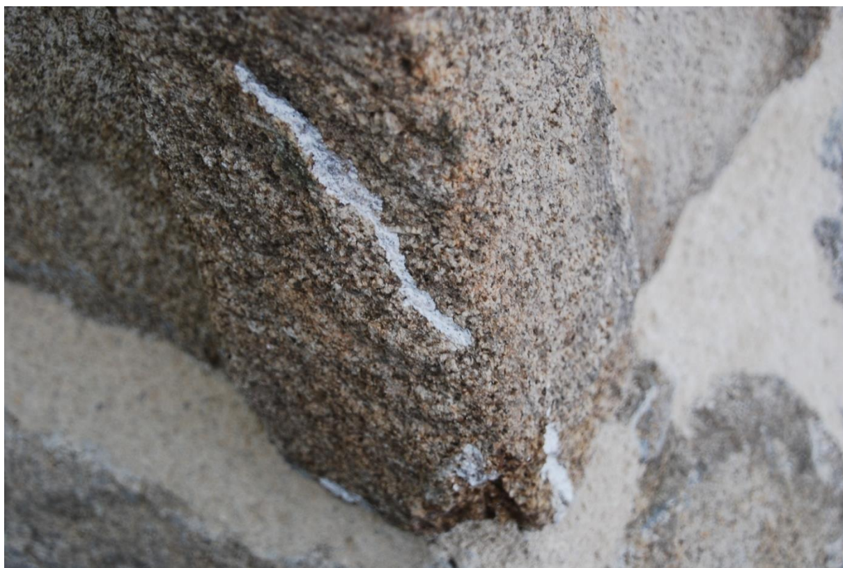
Průběh restaurování. Injektáž prasklin v minerálním materiálu- Wapo injekt. Detailní pohled na křížovou stěnu.
